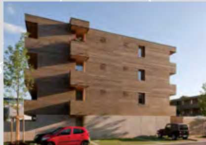
5 e% energieeffizienter Wohnungsbau Ansbach
