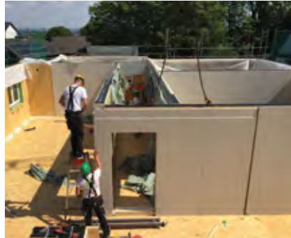
Dank Vorfertigung und Elementierung des Holzbaus konnten eine kurze Bauzeit, ein optimaler Bauablauf und eine exakte Kostenplanung erreicht werden.
