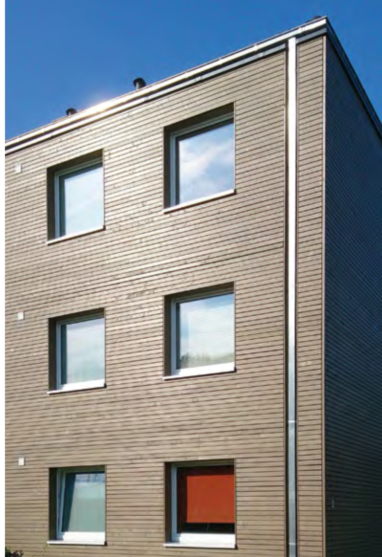
Der Einsatz von Holz und damit von leichten Elementen vereinfachte Transport und Montage auf der Baustelle.
