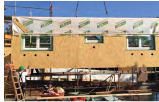
Dank Vorfertigung und Elementierung des Holzbaus konnten eine kurze Bauzeit, ein optimaler Bauablauf und eine exakte Kostenplanung erreicht werden.
